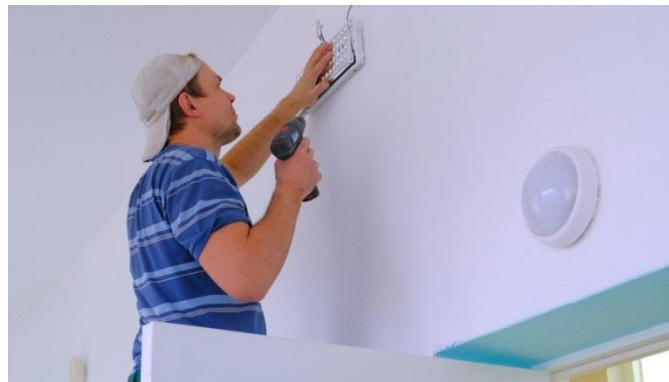
Капитальный ремонт поликлинического корпуса В Богородском филиале Кировской клинической больницы №7 им. В.И. Юрловой
